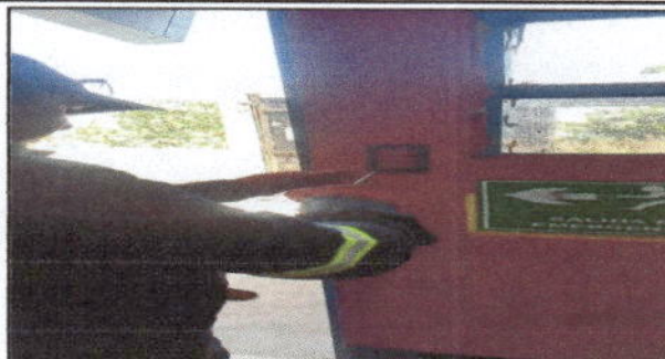
Foto 8: Se muestran foto de la sustitución de los interruptores.
